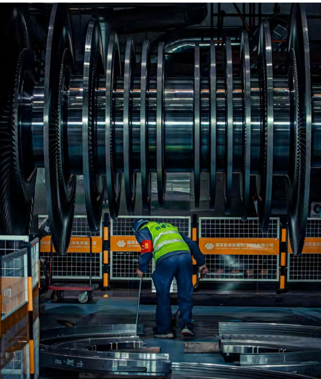
荆门公司 7 号机组低压缸转子检修中对称的线条
